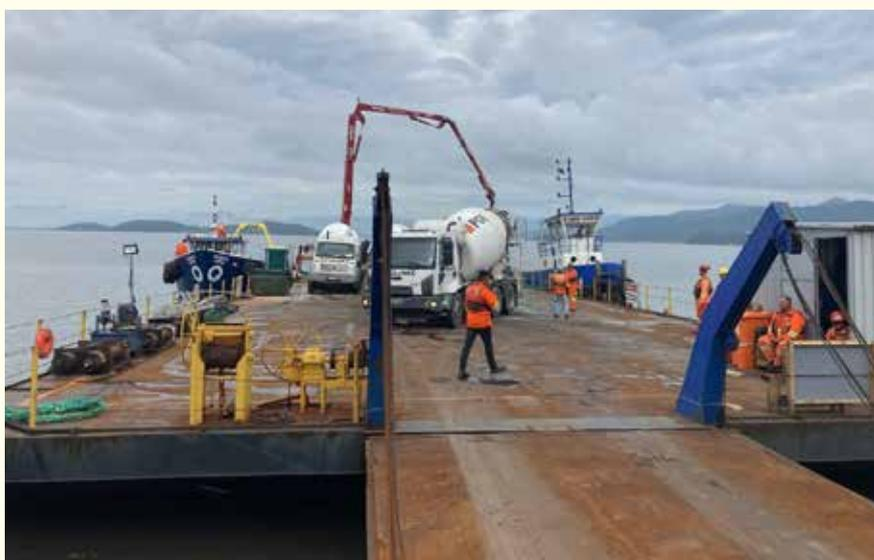
Figura 3. Embarque sequencial das betoneiras nas balsas.
