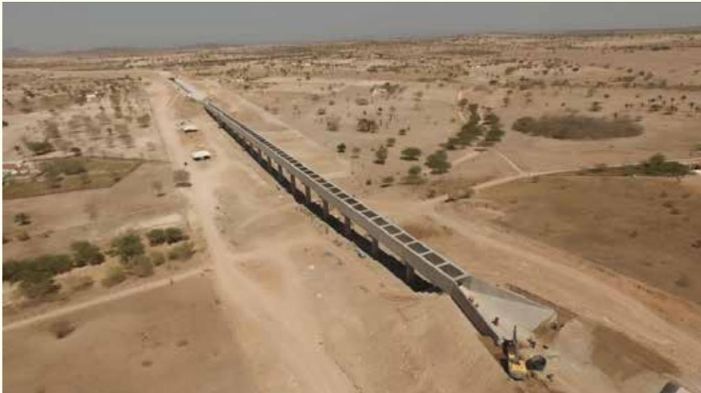
Figura 5. Exemplo de Ponte-canal construída (Trecho IV).
