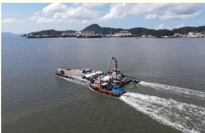
Figura 4. Condução da balsa por rebocadores até o local da concretagem.
